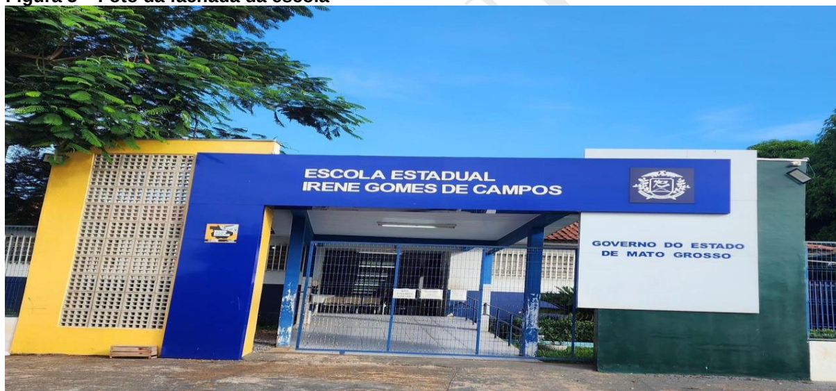
Figura 5 – Foto da fachada da escola
